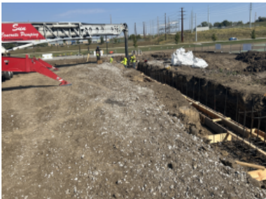
Grid Line 11 footing pour
