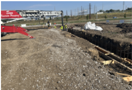
Grid Line 11 footing pour
